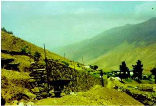
Baub dokumentation, Untere Stützmauer - Juli 2004
